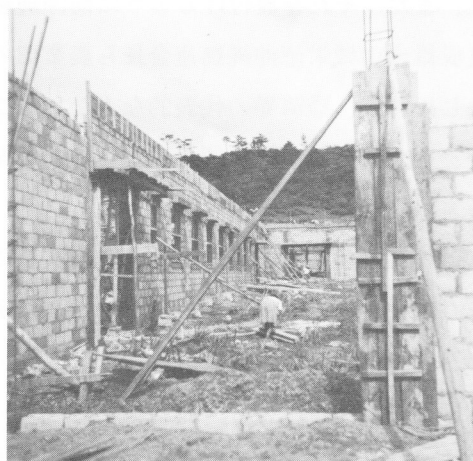
建設中の豊見城工場 （昭和27年6月）
