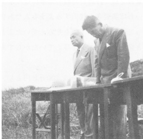
豊見城工場の地鎮祭 （昭和27年4月20日）
